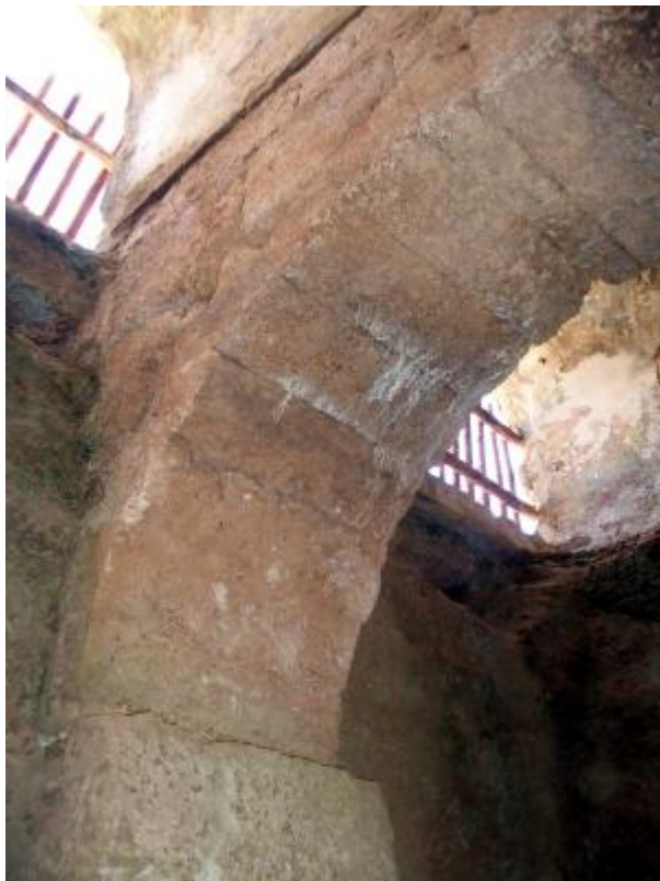
Detalle del arco de cantería que separa las Secciones de Excavación I y II . Puede apreciarse su punto de contacto con la roca tallada
